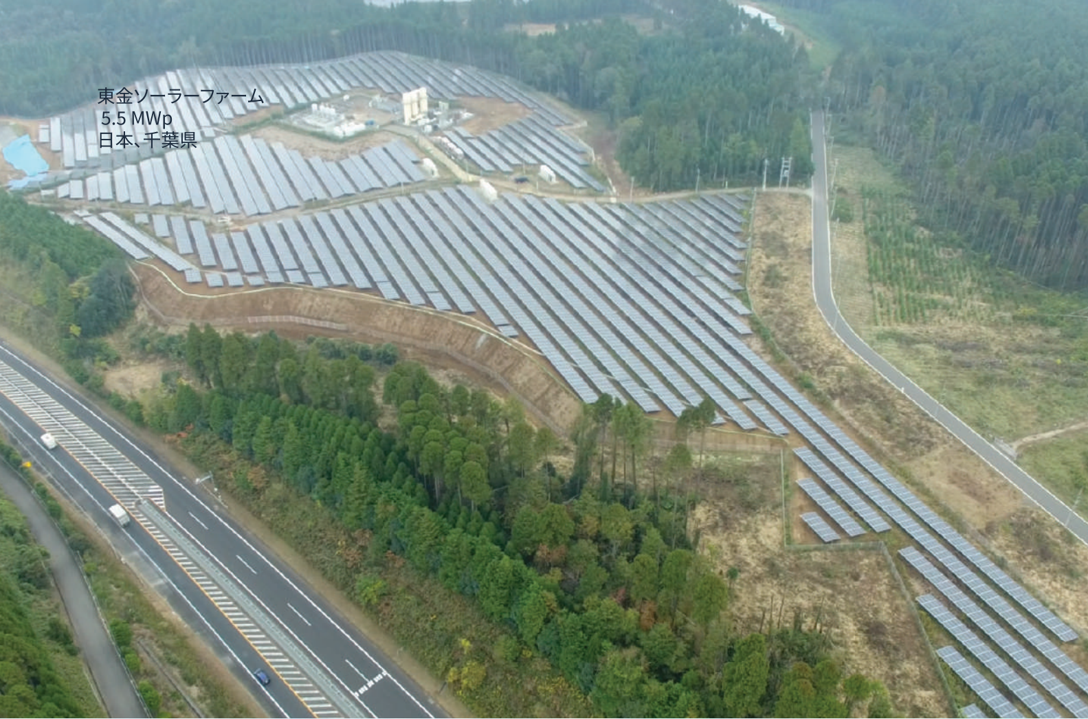
西白河ソーラーファーム 1.25 MWp 日本、福島県
