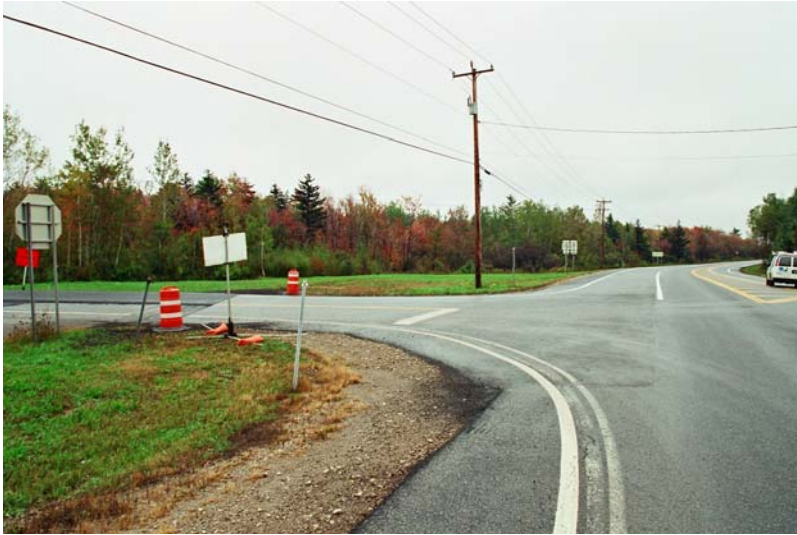
9a. SR 189 at US 11- NE Corner
