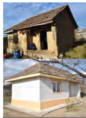
Antes y después de las obras
