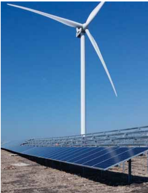
Central híbrida eólico-solar de El Conilete.
