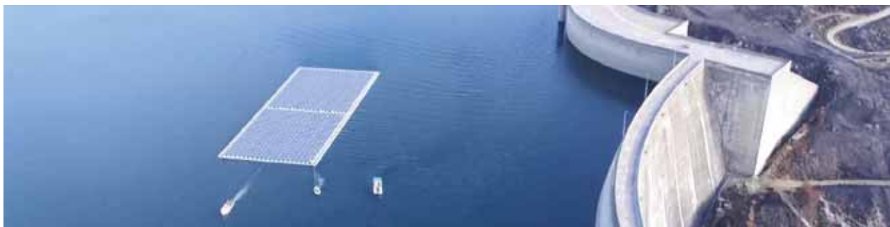
Planta solar flotante de Alto Rabagão
